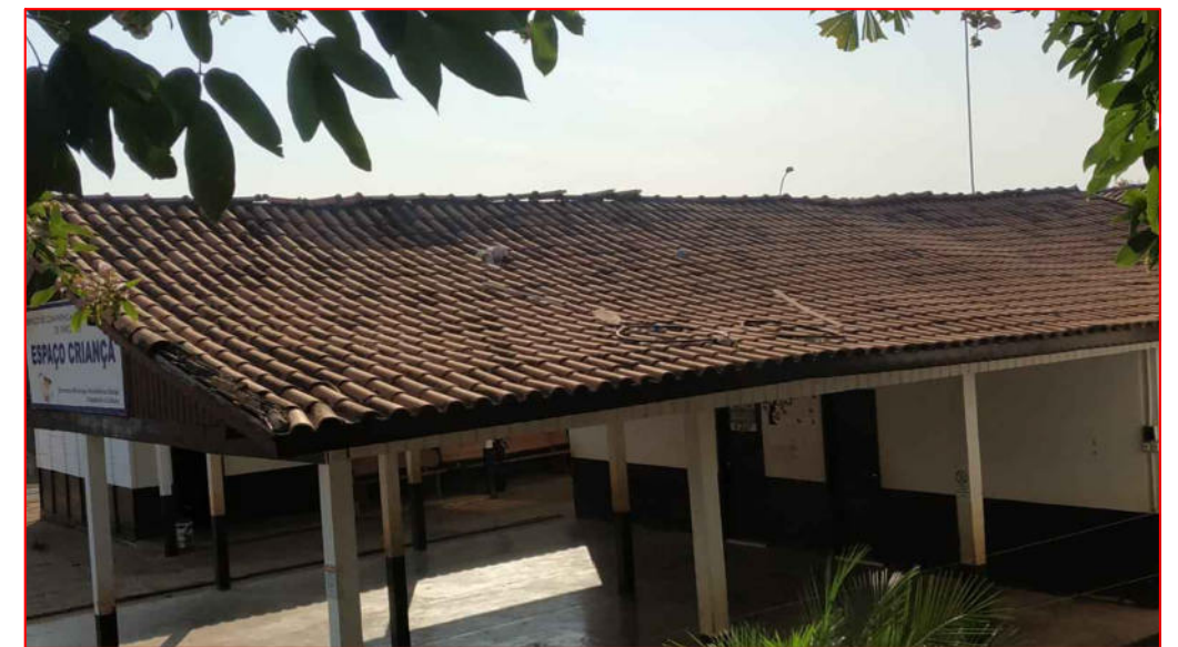
4 FOTO 02 - VISTA DO TELHADO (02/08/2019)
